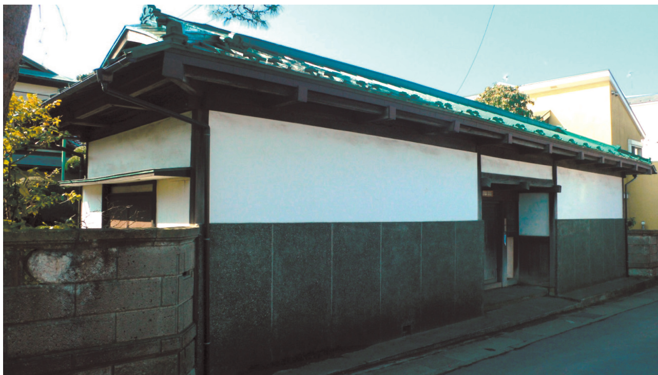
水越家長屋門北側外観
