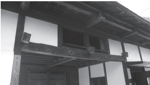
図2 南側軒 出桁造
