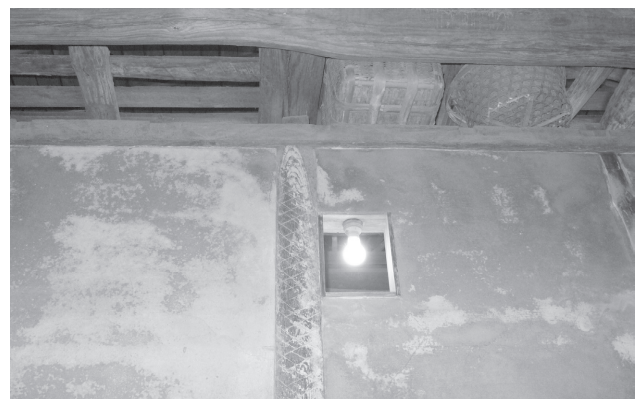
図 21 西側間仕切りの転用柱
