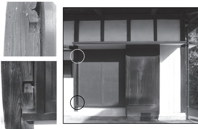
図10 東側部分 入口廻り痕跡(右写真の○部分を拡大)
